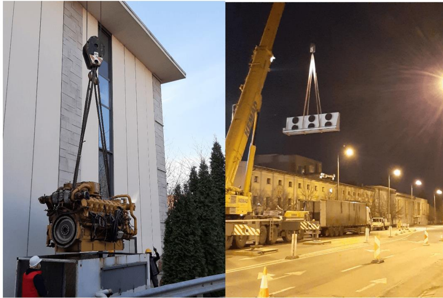
Agria Park motor és segédrendszer kiemelése
