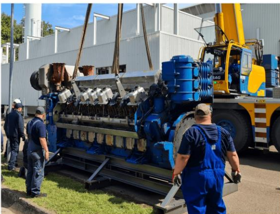
Tiszaújváros felújított motor beemelése
